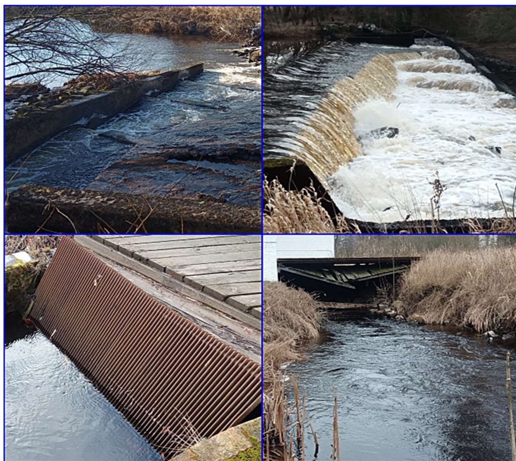
Figur 4: Bilder från Tönnersa kvarn i Genevadsån. Ovan till vänster: Laxtrappa. Ovan till höger: Fallet samt laxtrappa. Nederst till vänster: Fingringar innan turbiner. Nederst till höger: Fåra till turbiner.
