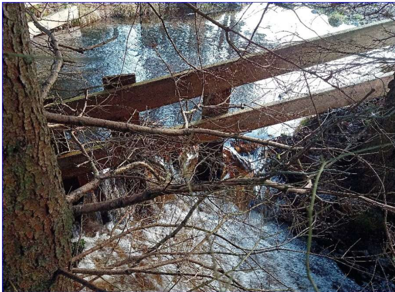
Figur 75: Vandringshindret i Balasjöbäcken (Balasjön – Älvasjön) består av uppdämmande plankor.
