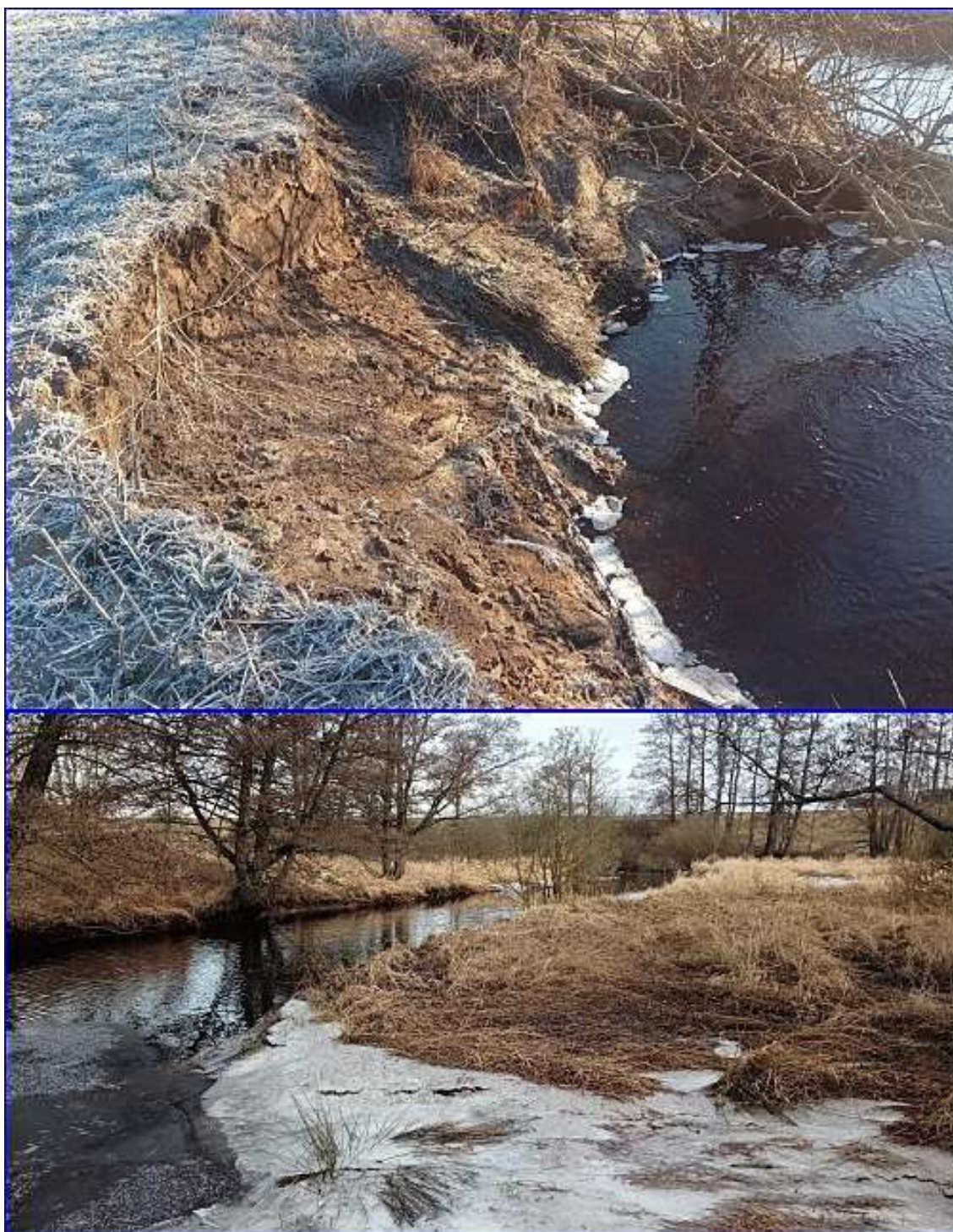
Figur 23: Översta bilden (sträcka 1) visar en generell bild över de dominerande fluviala processerna i Genevadsån/Brostorpsåns nedre delar i form av stranderosion. Nedre delen visar sträcka 5 strax norr om Öringe mölla där sedimentansamling har byggt upp stabila svämplan. Notera den mycket rika förekomsten av bladvass.
