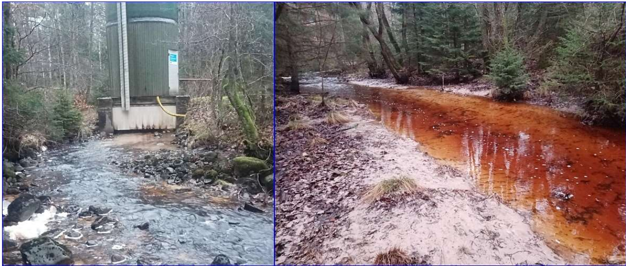
Figur 50: Kalkdoserare i Alslövsån/Börjeån till vänster i bilden. Bilden till höger visar sträckan nedströms doseraren där sedimentation och ansamlingar av kalk är påtaglig.
