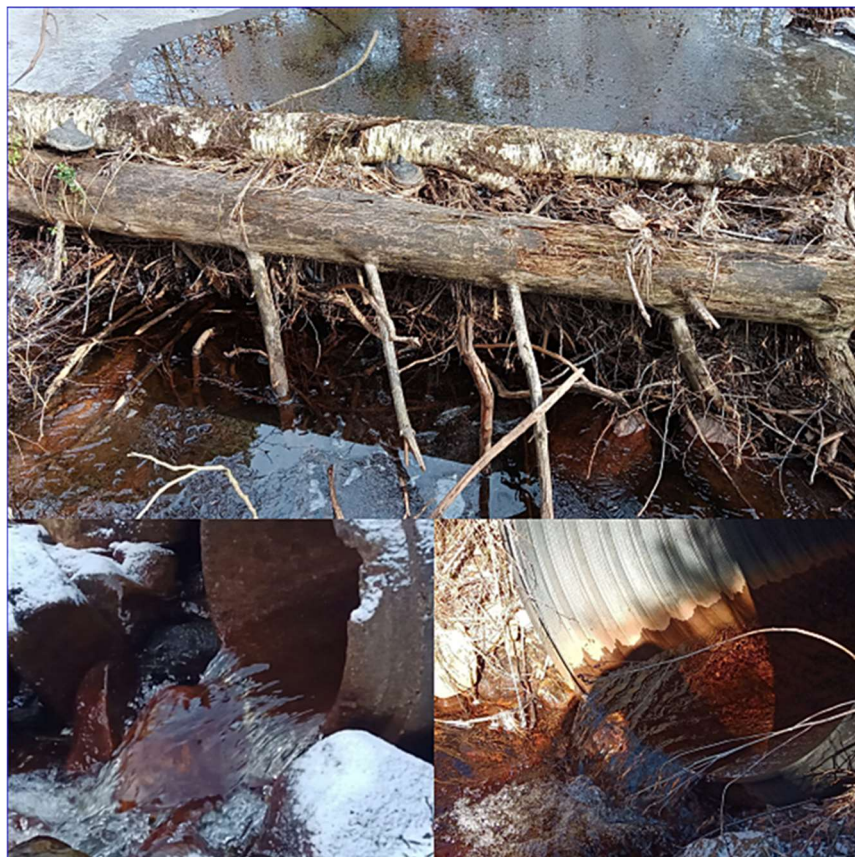
Figur 139: Exempel på vandringshinder i Öradebäcken. Övre bilden visar ett naturligt hinder (2). Nedersta bilderna visar vägtrummor som utgör hinder (3 och 6).
