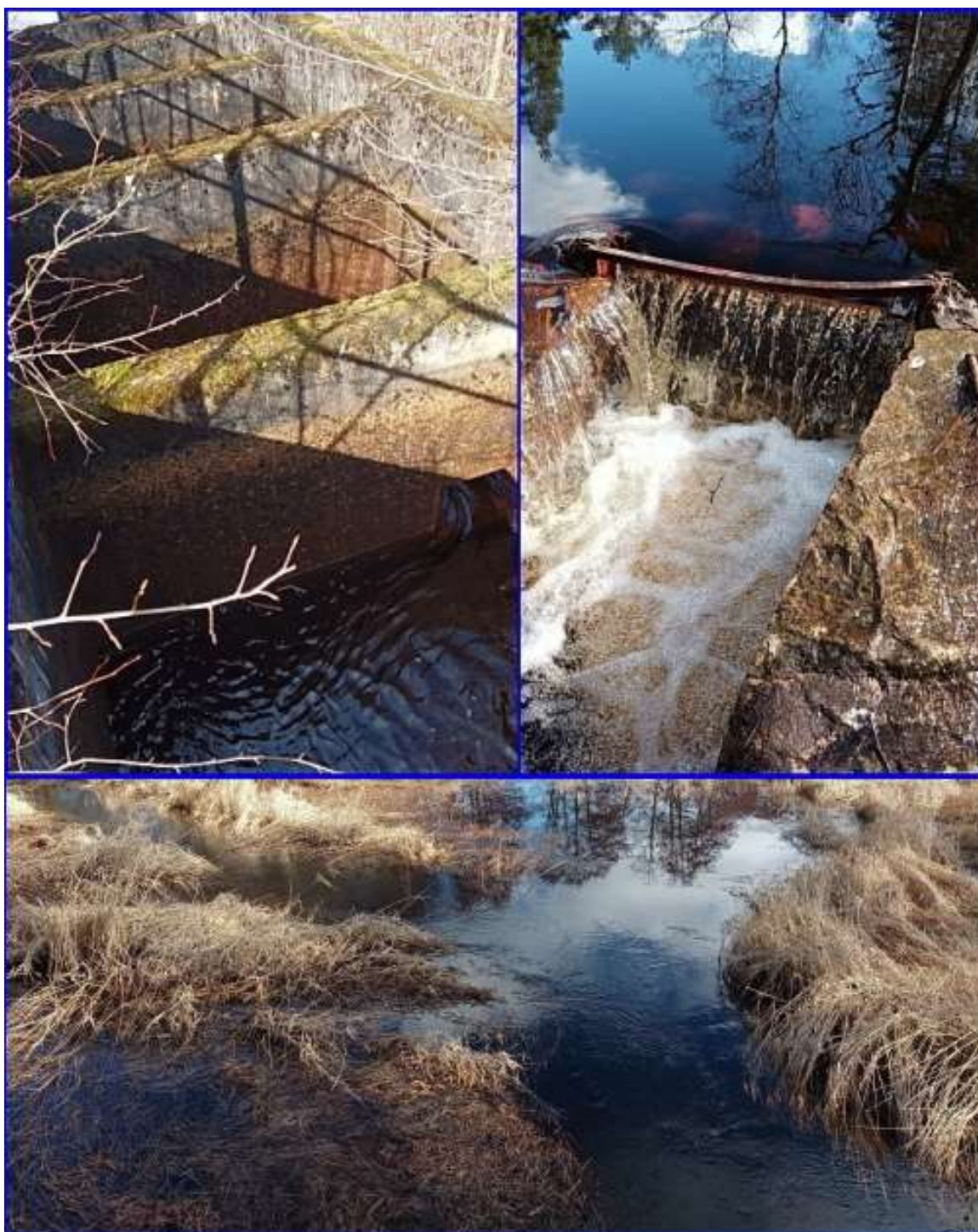
Figur 17: Bilden längs upp till vänster visar laxtrappan i Öringe mölla. Bilden längst upp till höger visar mittrännan som justeras manuellt vid dämningen uppströms Allareds mölla. Nedersta bilden visar inloppet till laxtrappa i Öringe mölla som håller på att växa igen.
