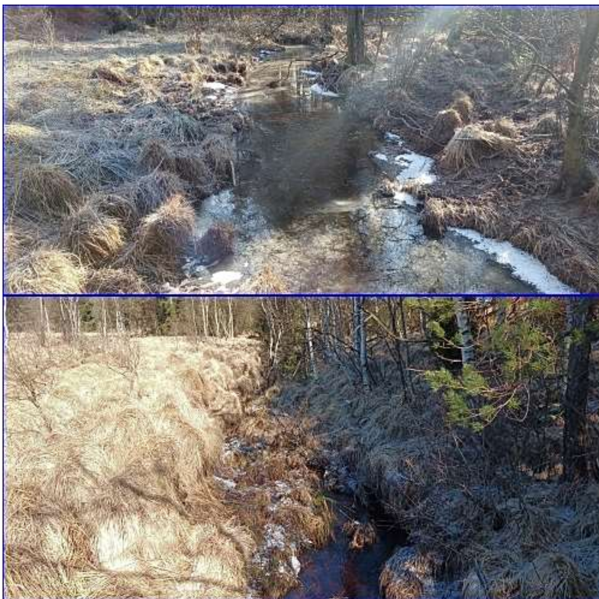
Figur 147: Översta bilden visar en Ex sträcka (sträcka 5) med en basnivå som tillåter vattendraget att svämma över vid högflöden. Den nedre bilden visar en rätad och omgrävd Tt sträcka (sträcka 25) där basnivån är mycket kraftigt sänkt och vattendraget rinner över stenspås. Notera den stora skillnaden i inneslutning och bankfullnivåer. Torvmarken på den nedre bilden har börjat torka ut och bli trädbevuxen.
