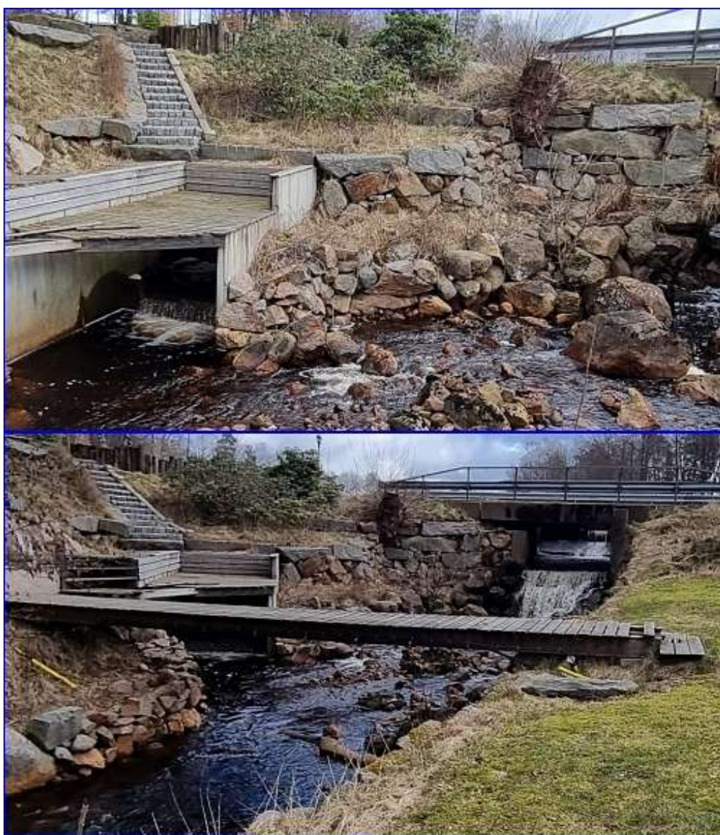
Figur 93: Övre bilden visar utloppet på fiskvägen vid Bölarps kvarn (vandringshinder 1). Nedre bilden visar utloppet på dammen vid Bölarps kvarn (vandringshinder 1).
