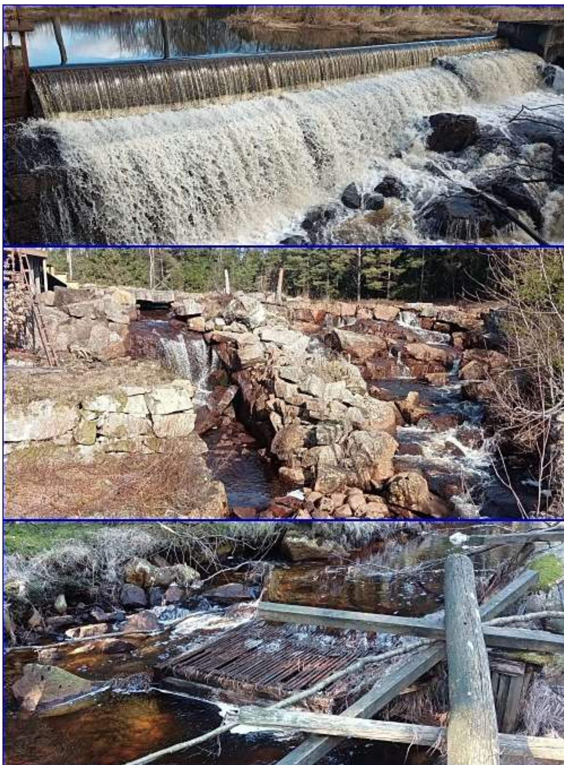
Figur 16: Exempel på vandringshinder i Genevadsån/Brorstorsån. Övre bilden till vänster visar Öringe mölla (1). Mittersta bilden till visar en uppdämd damm vid ett naturligt fall (5). Nedersta bilden visar en gammal ålkista (6).
