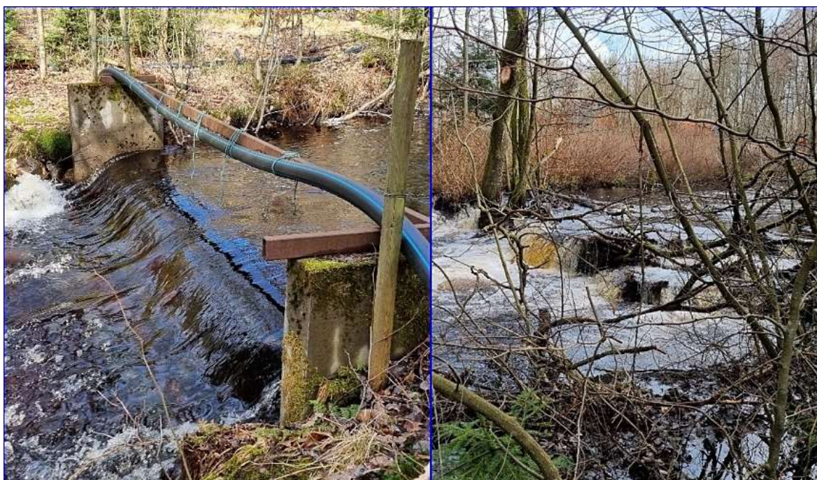
Figur 31: Vandringshinder 3 bilden till vänster och vandringshinder 4 bilden till höger. Dessa två vandringshinder ligger ca 30 meter ifrån varandra. Inget av dem utgör definitiva hinder för fisk då det finns fåror runt hindren vid medel- och högvattenflöde.
