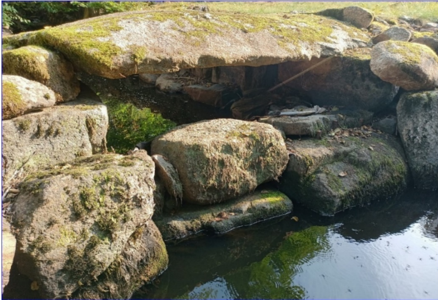
Figur 18: Dämmande block har lagts i vattendraget.
