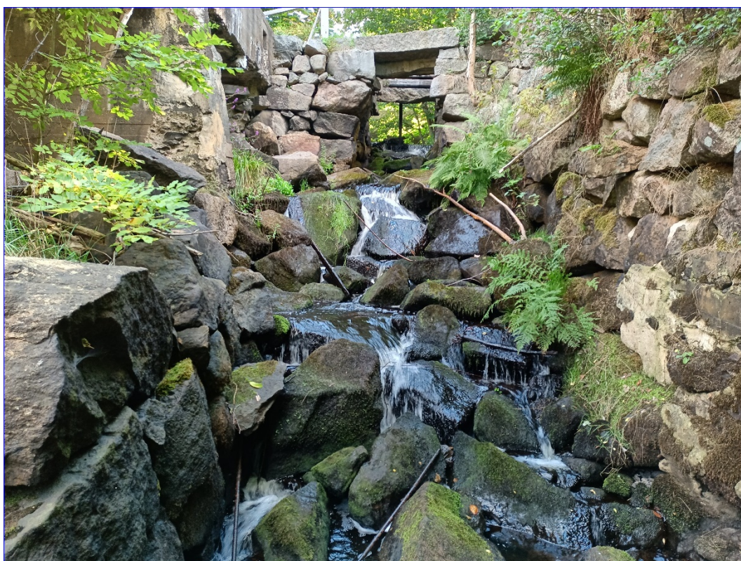
Figur 16: Fåran upp till utloppet där dammluckorna tidigare varit belägna saknar pooler och eventuellt hade mindre justeringar med omfördelning av block och sten kunnat möjliggöra en passage för öring.
