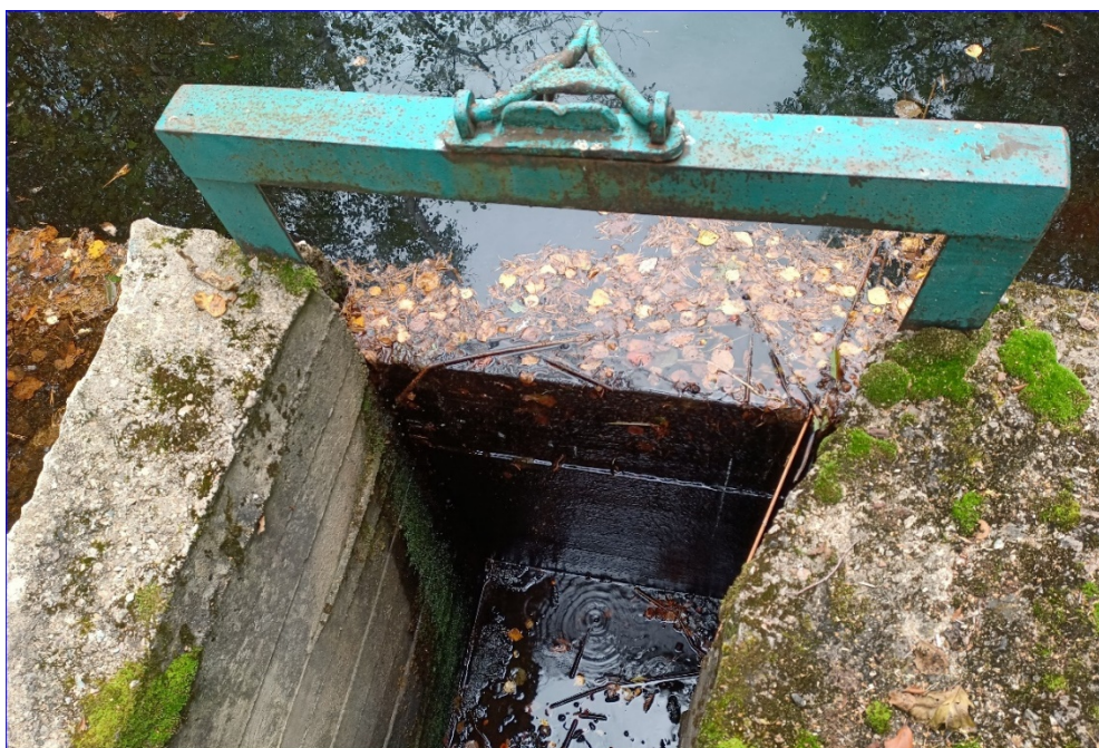
Figur 2: Regleringsluckan vid sågdammen norr om Elsebrånevägen tillät endast minimalt med vatten att passera och ansluta till vattendraget.
