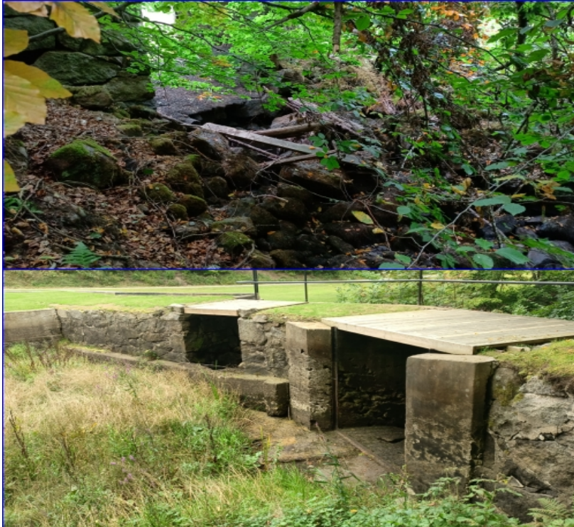
Figur 5: Resterna av Kopprarps kvarn utgör idag ett definitivt hinder för öring men omfattande åtgärder kan möjliggöra en passage för åtminstone starksimmande arter.
