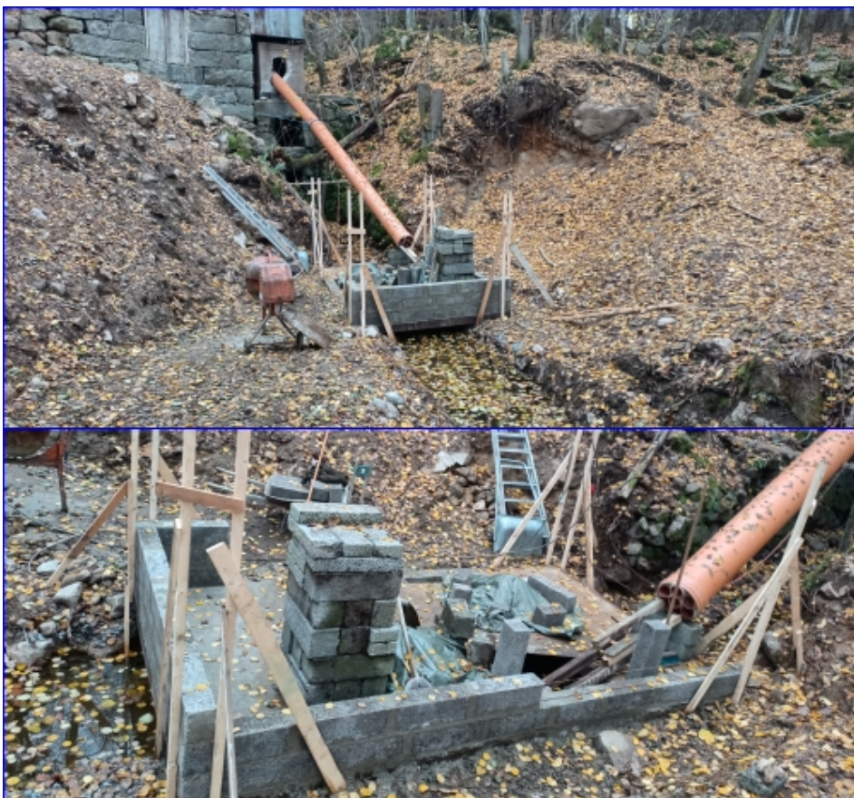
Figur 4: Ett nytt turbinhus och nya turbinrör höll vid karteringstillfället på att installeras nedanför kraftverks/kvarnbyggnaden
