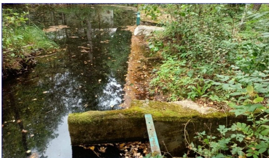
Figur 9: Dämningen till sågdammen har två utlopp/luckor som utgjorde definitiva hinder
