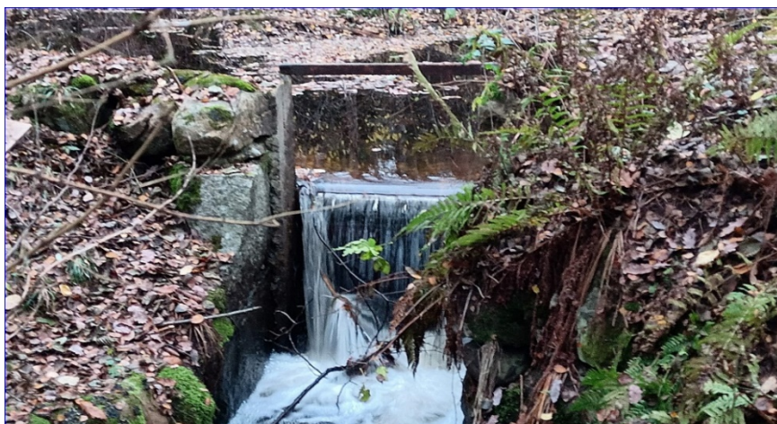
Figur 8: Den första regleringsluckan vid dammen innan kraftverket som utgjorde ett
