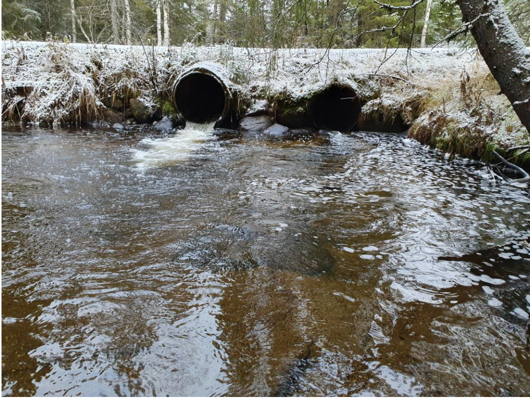
Figur 30. Denna vägtrumma är vandringshinder nummer 6. Trumman är bedömd till ett partiellt hinder för öring.
