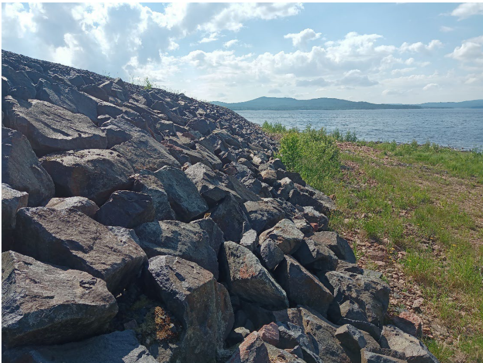
Bild 3: Vallen mot Letten är uppbyggd av sprängsten.
